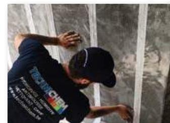
Sur la TECHNI-PLASTER MEMBRANE il peut aussi être appliqué à nouveau une couche de TECHNIFLEX 2K, de sorte à ce que la TECHNI-PLASTER MEMBRANE soit complètement «englobée» dans le produit TECHNIFLEX 2K. Par la suite il est bien entendu possible de plafonner sur le TECHNIFLEX 2K.
