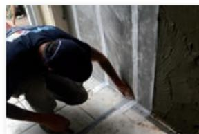
2) Le TECHNIFLEX 2K est utilisé comme «badigeon colle» pour la mise en œuvre de la E104 TECHNI-PLASTER MEMBRANE.
